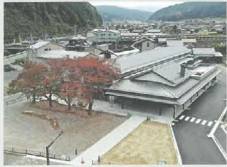
工事完成、桜の紅葉が美しくまちに溶け込んだ景観となりました
