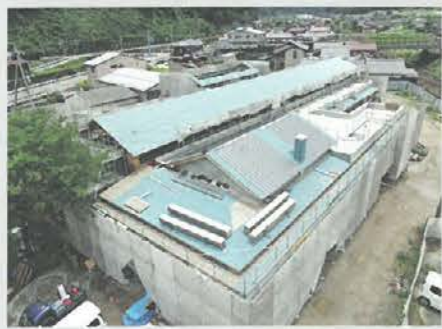
屋根工事中、建物全体のボリュームが見えてきました
