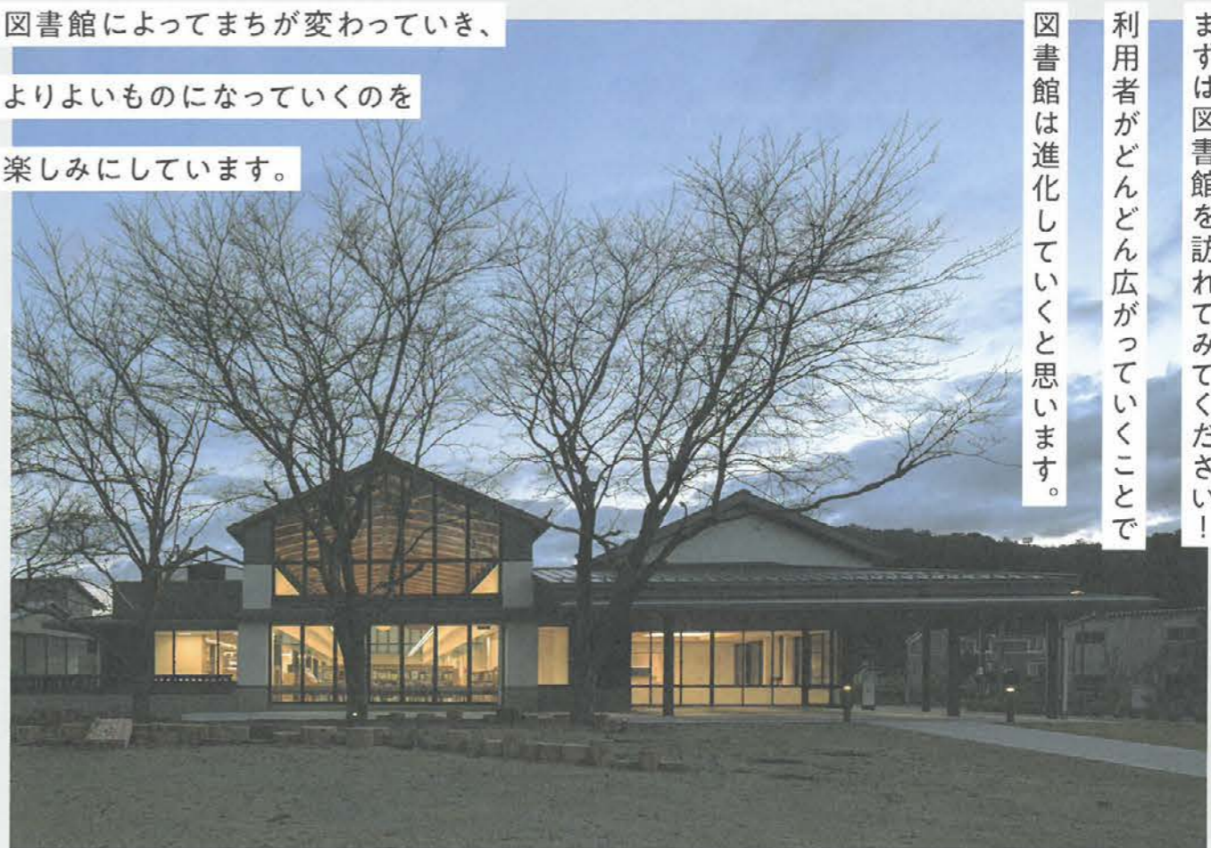
原っぱ越しの夕景 智頭町の屋根トラスと図書館内部の様子が浮かび上がります
