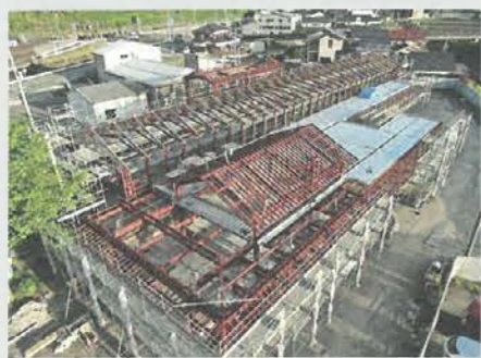
鉄骨建方完了し、智頭町の屋根トラスを設置しました
