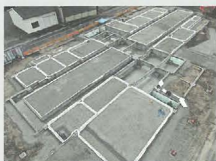
基礎工事が完了し、建物の形状がはっきりしてきました
