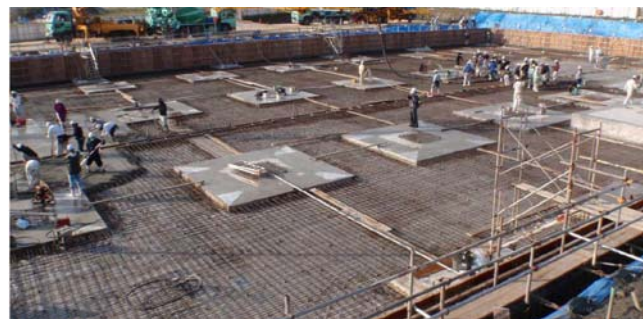
<図8：基礎施工時の風景>
